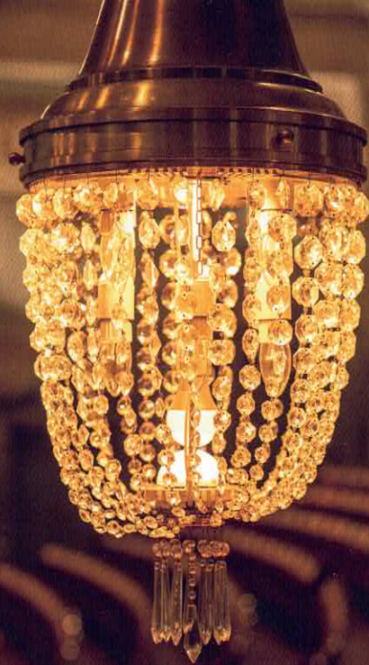
Kronleuchter mit Fade-to-Warm-Technologie: Charakter des Halogenlichts bleibt erhalten. Foto: ETC
